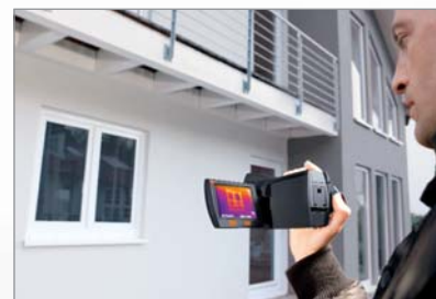
Строительная термография с testo 876
