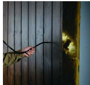
Проверка качества теплоизоляции
